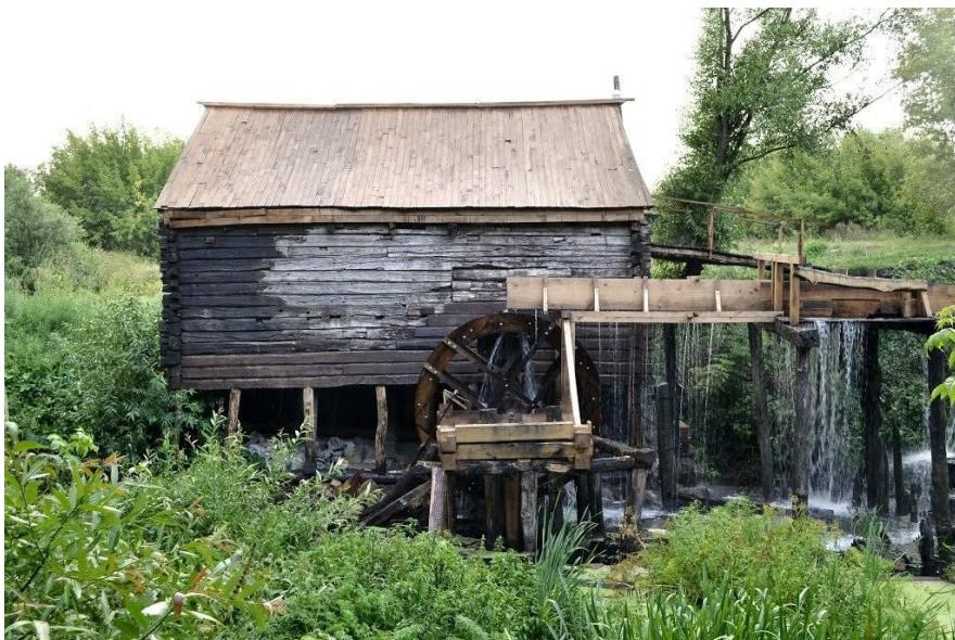
Водяная мельница использует силу воды. Их строили обычно возле рек с быстрым течением. У водяной мельницы на колесе есть специальные лопатки. Когда вода течёт, она упирается в эти лопатки и приводит в движение всё колесо. Сейчас я вам покажу принцип вращения колеса. (Демонстрация макета мельницы в действии).
